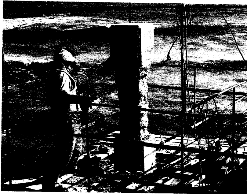
Imagen N°02.- Descabezado de pilotes.
